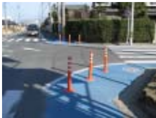
東田町交差点の安全対策
